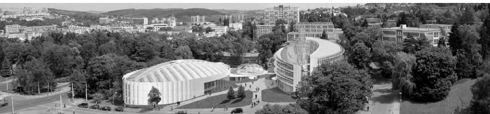
Projekt Kongresového a univerzitního centra (realizace v roce 2007, autorka prof. Eva Jiříčková).
